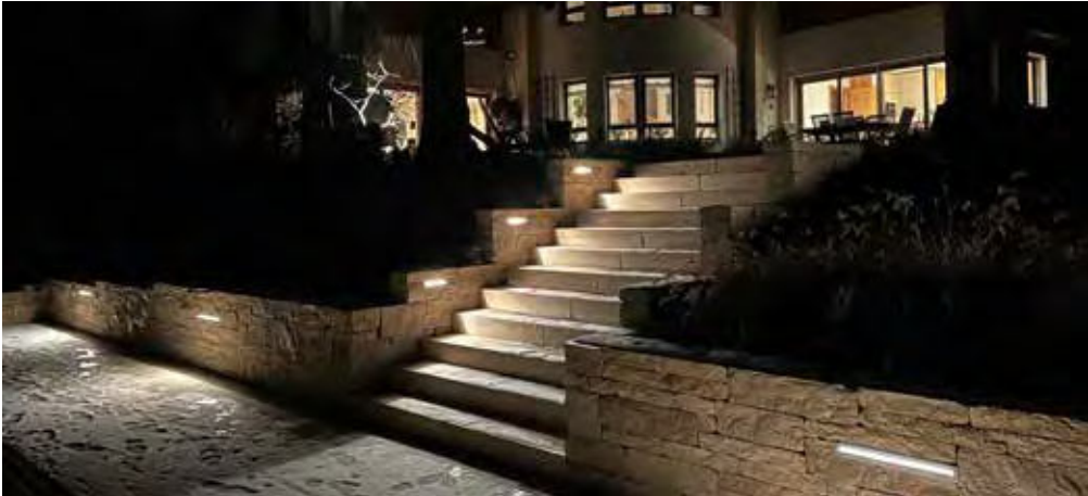
Down Light, Treppenbeleuchtung
