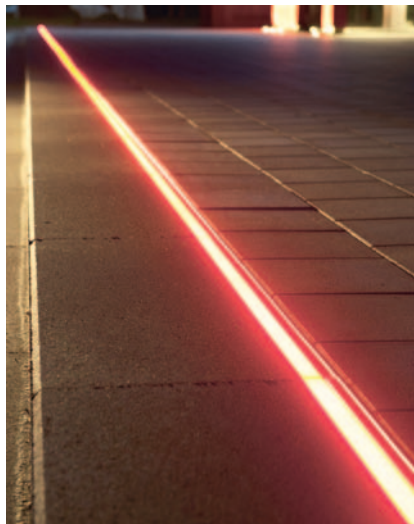
Die ACO-Lichtlinie ist kaum als Entwässerungsrinne erkennbar.
