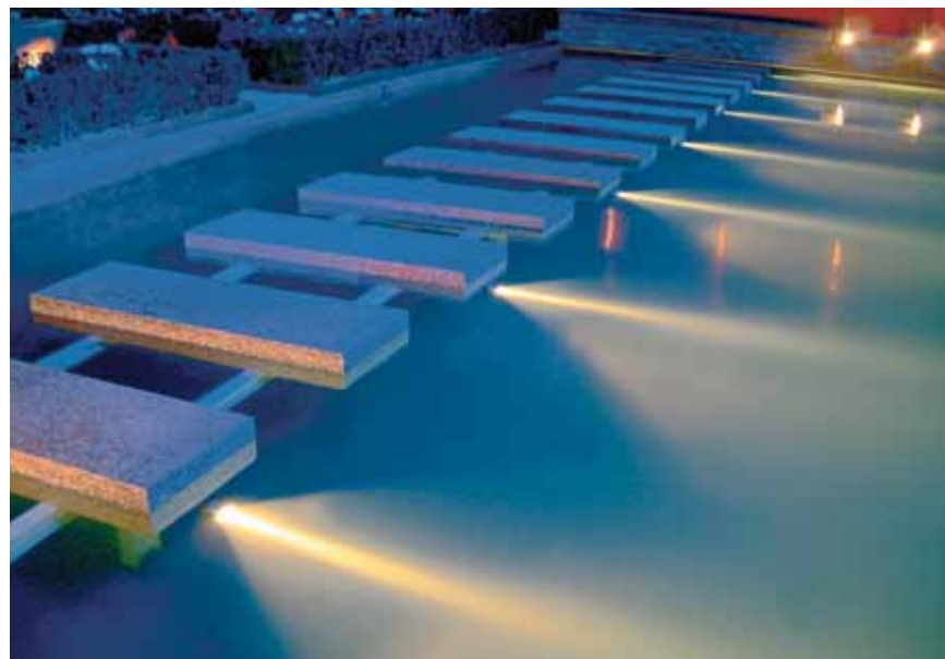
Schwimmteich mit Unterwasser-Scheinwerfern, 50 Watt 10°.
