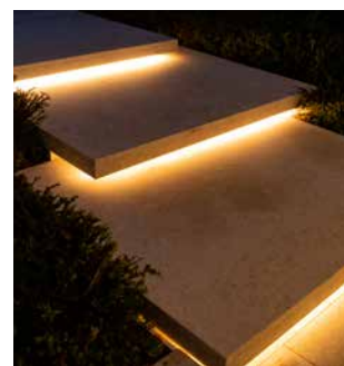
Linear Line Micro, éclairage des marches
